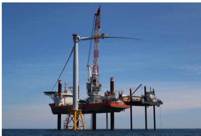
Figura 3-10. Brave Tern, uma embarcação do tipo Jack-up a instalar pás de turbina eólica no parque offshore fixo de Block Island em Taiwan, 2016. Fonte: Recharge News 70
