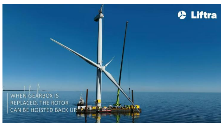
Figura 3-11. Substituição de uma caixa de velocidades numa turbina eólica offshore fixa utilizando a grua de nova geração da Liftra. Fonte: Liftra 71
