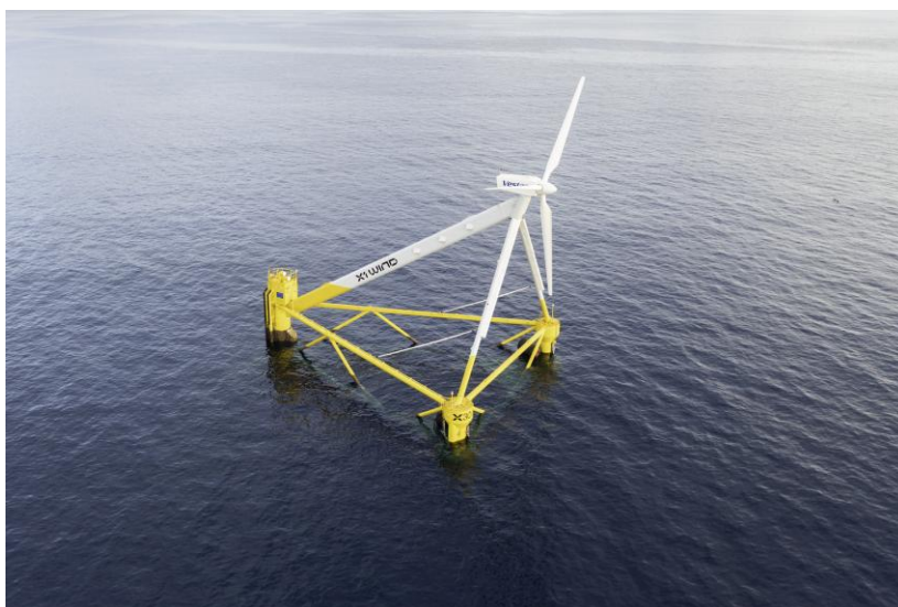
Figura 3-2. Turbina eólica flutuante com rotor a jusante (downwind) desenvolvido pela X1Wind
